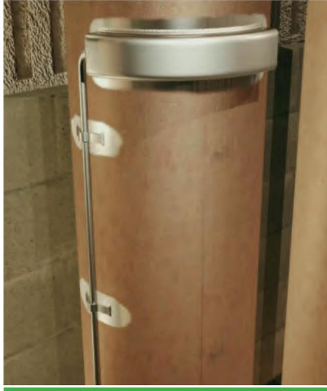
使用夹子的正确走线方式
